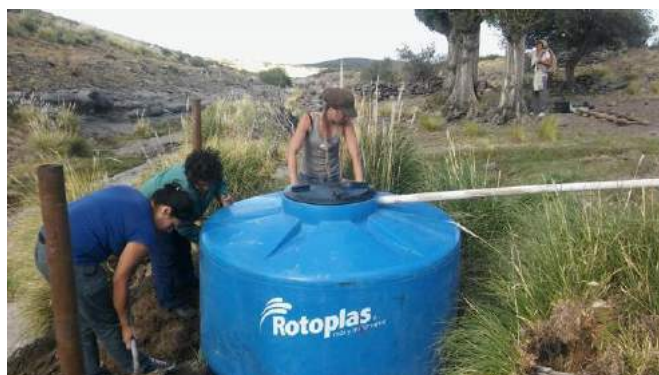
Imagen n°2: Trabajos de captación de agua por las productoras de las comunidades (6)
