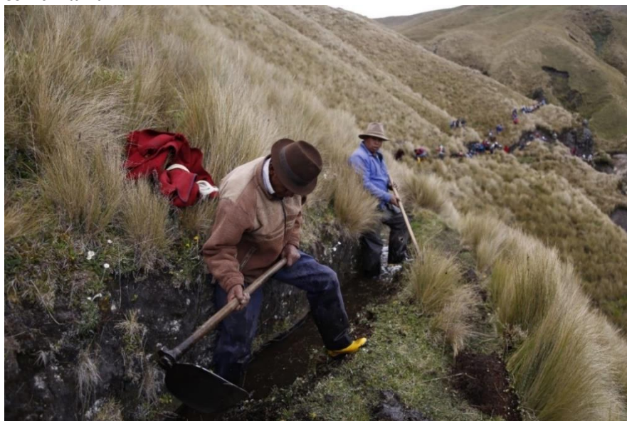
Imagen 3. Comuneros limpiando los canales de agua en la minga comunitaria
