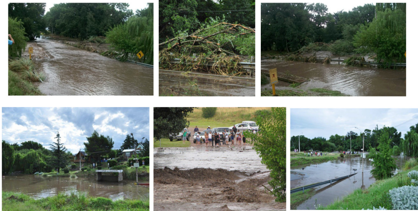
Figura N° 5. Desborde y crecida del arroyo San Bernardo (25/01/2011)
