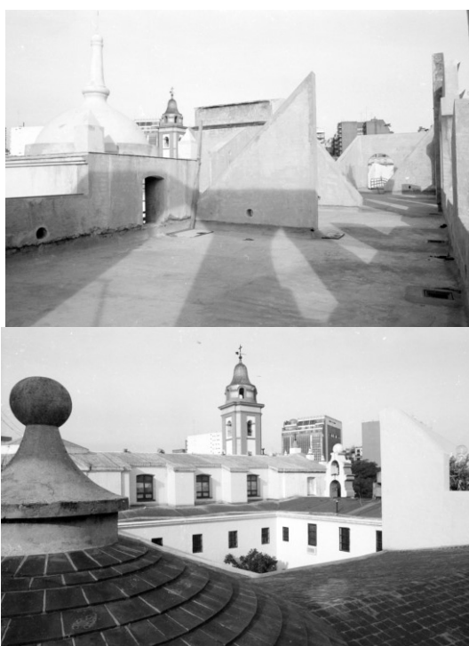
Imagen 2. Techos del Centro Cultural Ciudad de Buenos Aires, en obras
