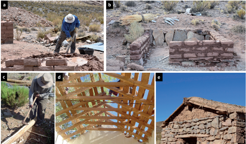
Figura N° 3. Técnicas de construcción que involucran el uso de especies vegetales. a) preparación de barro, b) muro de adobe en construcción, en la esquina superior izquierda puede observarse un atado de paja para la construcción, c) preparación de maderas de cardón para la construcción, d) estructura a dos aguas del techo, e) resolución final de la cubierta con barro y paja.
